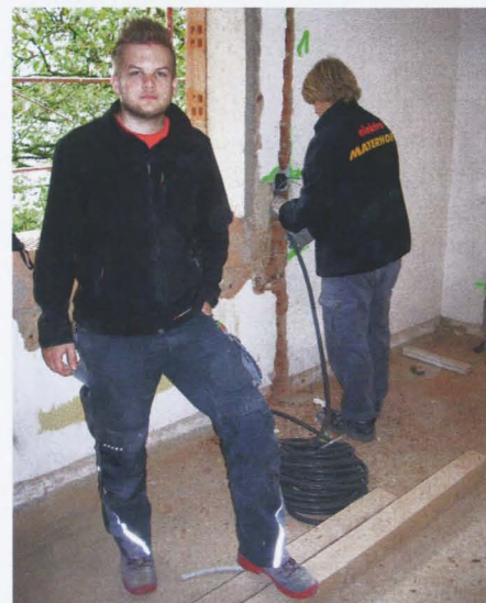
Auch Jakob Mayerhofer, der Neffe des Firmenchefs ist von den vorverdrahteten Schläuchen angetan: „Man spart sich einen Arbeitsschritt und ein Mann auf der Baustelle genügt. Das ist gerade in einem kleinen Betrieb von Vorteil.“
